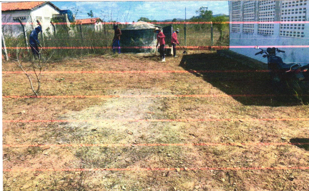
Limpeza manual de terreno com enxada
